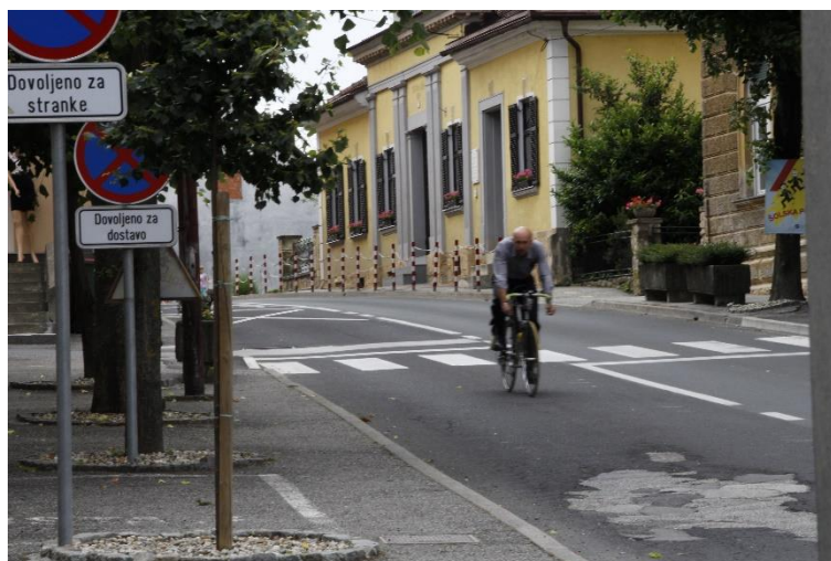
Slika 5-14: Kolesar se mora izogibati poškodovanemu delu vozišča.
