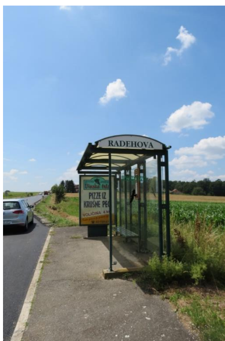
Slika 4-33: Postajališče Radehova- v času obnove.
