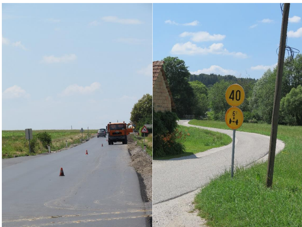
Slika 4-17: Desno- Obnova državne ceste v naselju Radehova. Levo- tipična lokalna cesta
